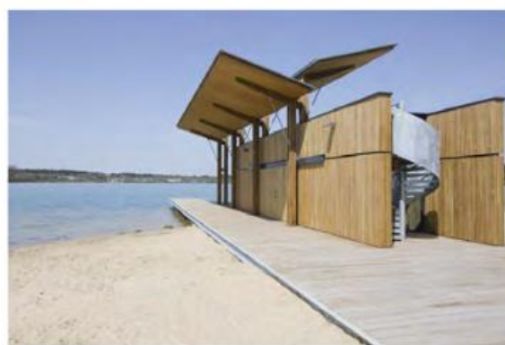
Aménagement réalisé sur le site d'Arjuzanx
